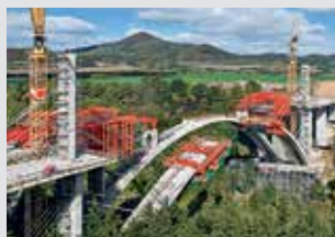
Coffrages de ponts
