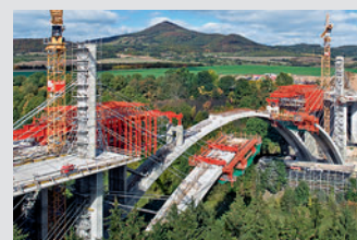
Coffrages de ponts
