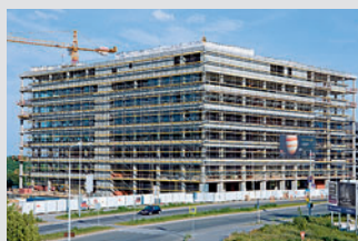
Echafaudages de façades
