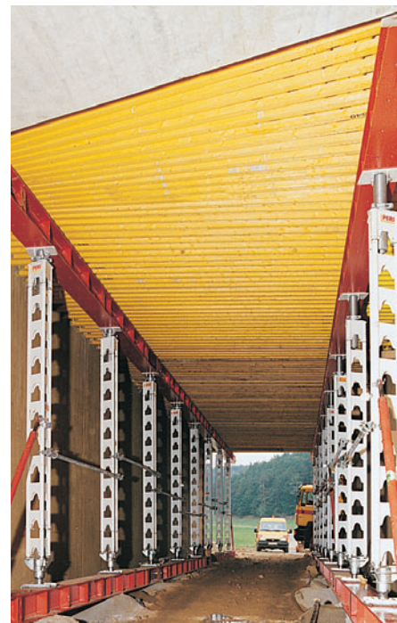
60 ml de superstructure de chaussée positionnés sur des étais HD 200.
