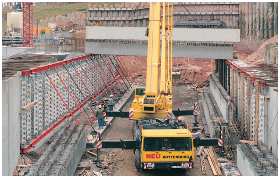
PERI HD 200 pour l'étalement de poutres en béton précontraint préfabriquées.
