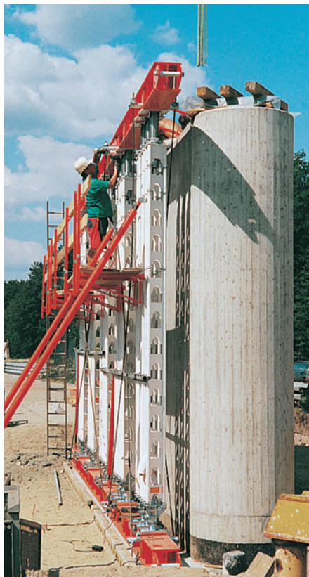
La console 75 HD pour un échafaudage de 75 cm de large. Distance maxi 1,25 m. Charge adm. 150 kg/m 2 .
