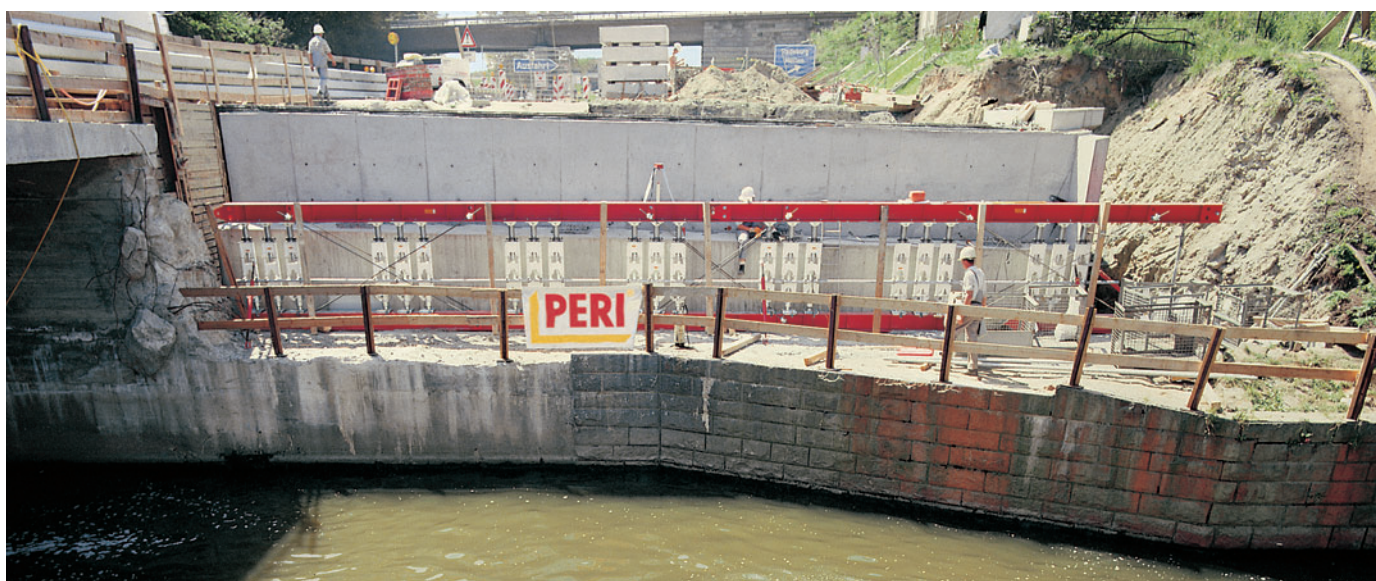
L'étais à forte charge HD 200 s'utilise également de manière rentable pour les petites hauteurs.
