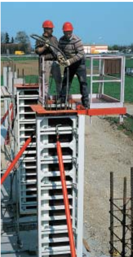
Plate-forme de bétonnage PERI pour un travail en toute sécurité à n'importe quelle hauteur.
