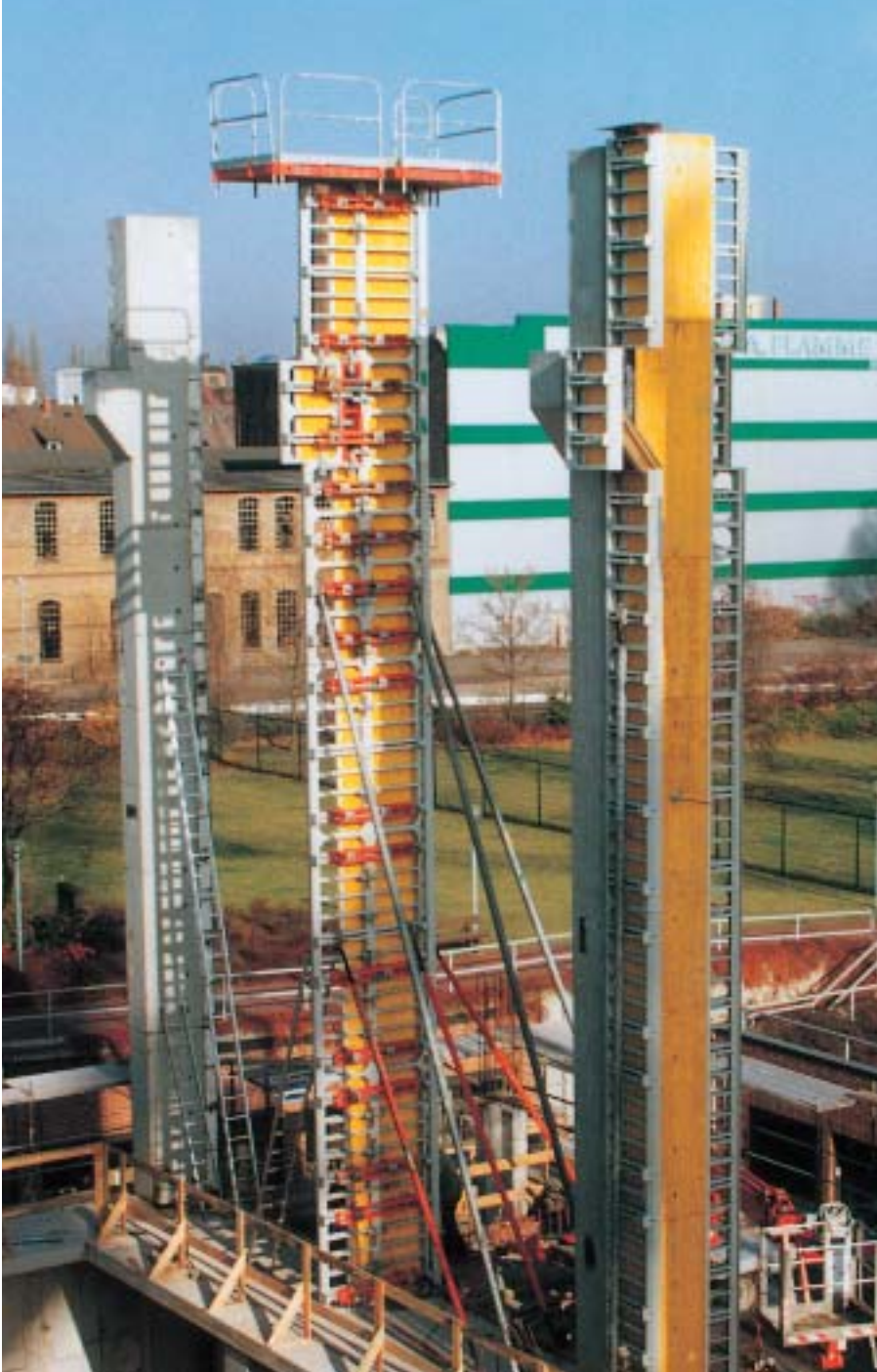
Poteaux de grande largeur hauts de 14 m, avec consoles de grue. La haute pression de béton admissible du système RAPID permet un placement de béton rapide.
