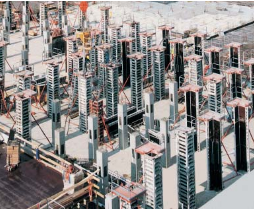
Le coffrage poteau pour un béton brut de décoffrage
