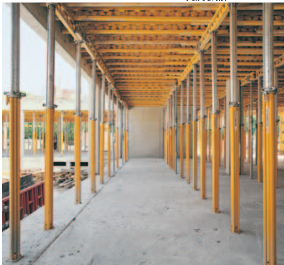
Etais MULTIPROP 350 et coffrage de dalles MULTIFLEX.
