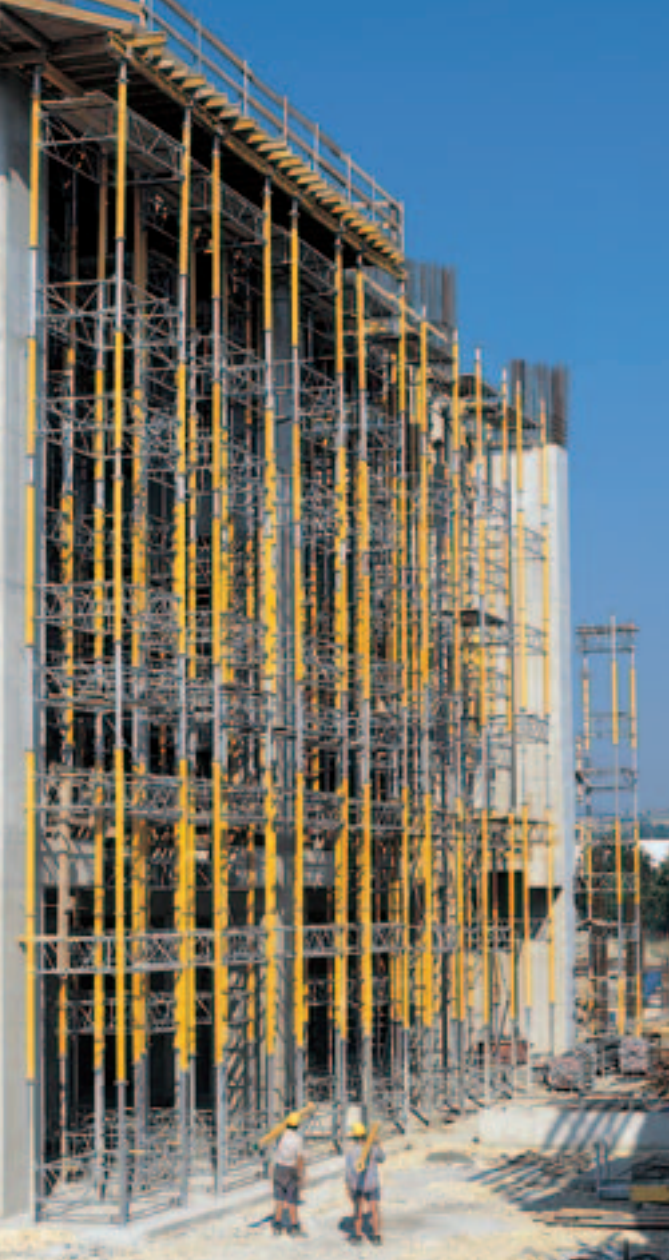
Tours MULTIPROP, hautes de 20 m, pour l'étaielement d'une dalle en encorbellement.
