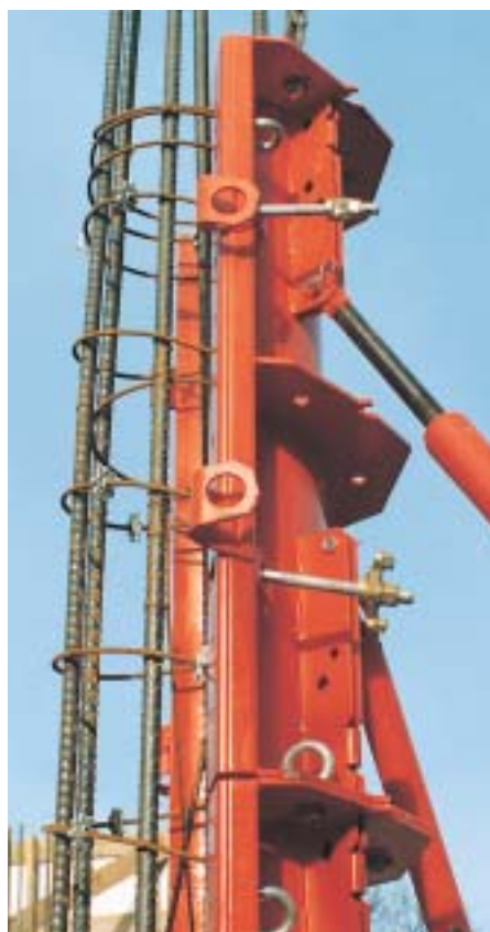
Chaque élément poteau comporte des points de raccordement d'étais tirant-poussant.
