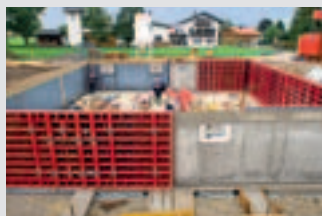
Coffrages de voiles
