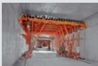
Coffrages de tunnels
