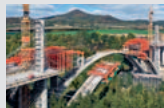
Coffrages de ponts
