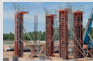
Coffrages de poteaux
